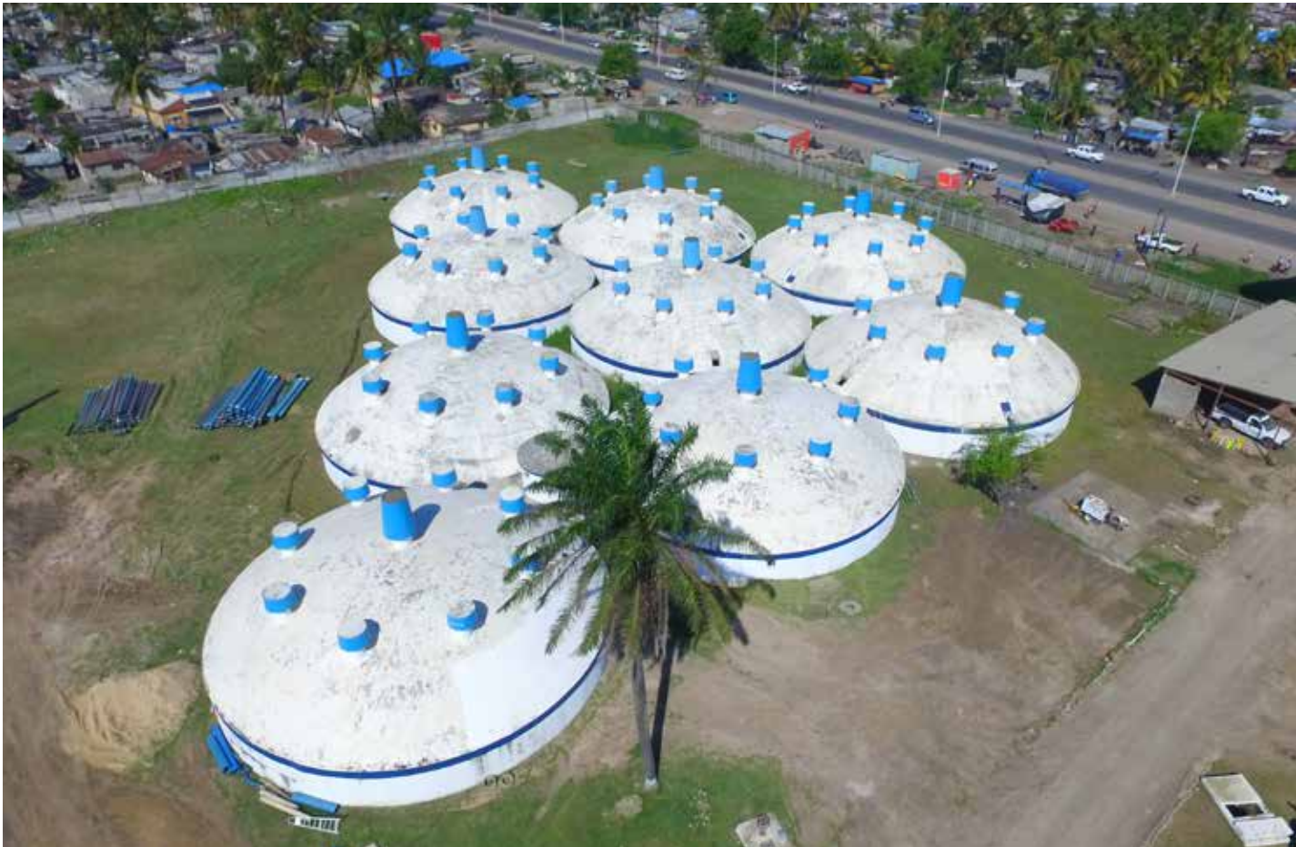
Centro Distribuidor da Munhava (Depositos)
